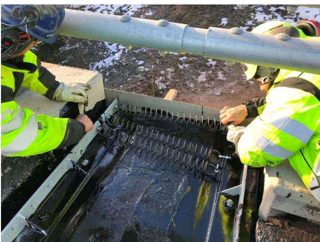
Kuva 17. Jousien asennus polymeeribitumiseen massaliikuntasäumaan
