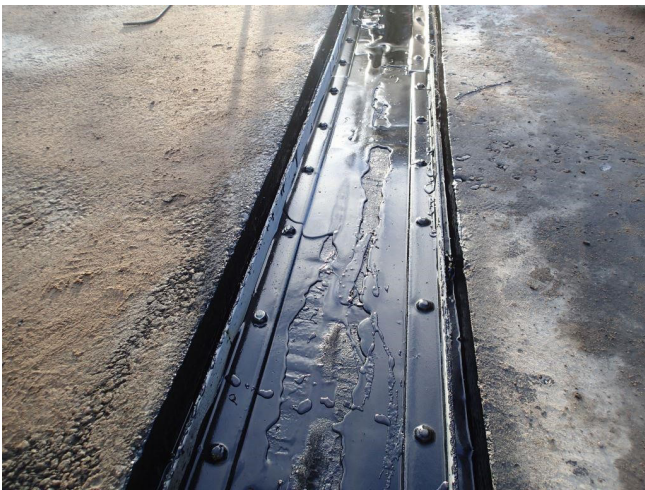
Kuva 16. Teräsosilla vahvistettu polymeeribitumisen massaliikuntasäumalaite tekoprosessin aikaan, jousia ei ole vielä kiinnitetty
