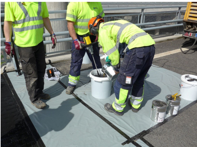
Kuva 20. Bitumittoman polymeerimassaliikuntasauman komponenttien sekoitus. Työn ulkopuoliset alueet on suojattu esimerkiksi. Valu on edennyt jousien yläpinnan tasolle
