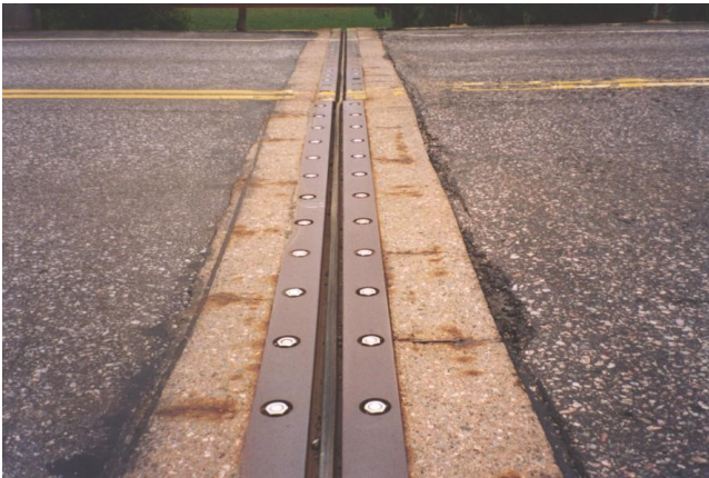
Kuva 27. Ruuvikiinnitteinen yksikuminen liikuntasaumalaite R15 / DC-7
