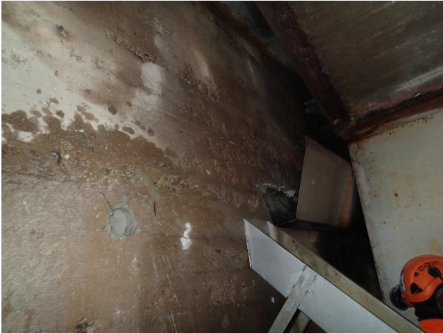
Kuva 26. Hulevesikouru avoimen liikuntasaumalaitteen alapuolella ja vedenjohtolaite hulevesikourun päässä. Hulevesikouru otsamuurin ja päällysrakenteen välissä
