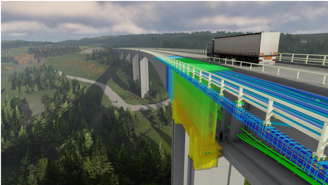
Kuva 29. Laajennetun todellisuuden malli siltapaikasta (Sweco).
