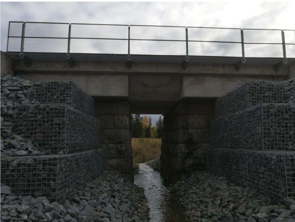
Kuva 2. Teräsbetoninen laattasilta, elementtirakenteinen (BIe). Kuuttilan ratasilta (H-3068), Sastamala.
