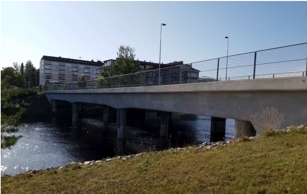
Kuva 13. Teräsbetoninen jatkuva ulokekaukalopalkkisilta (Bjukaup). Haapasalmen ratasilta (SK-3001), Savonlinna.
