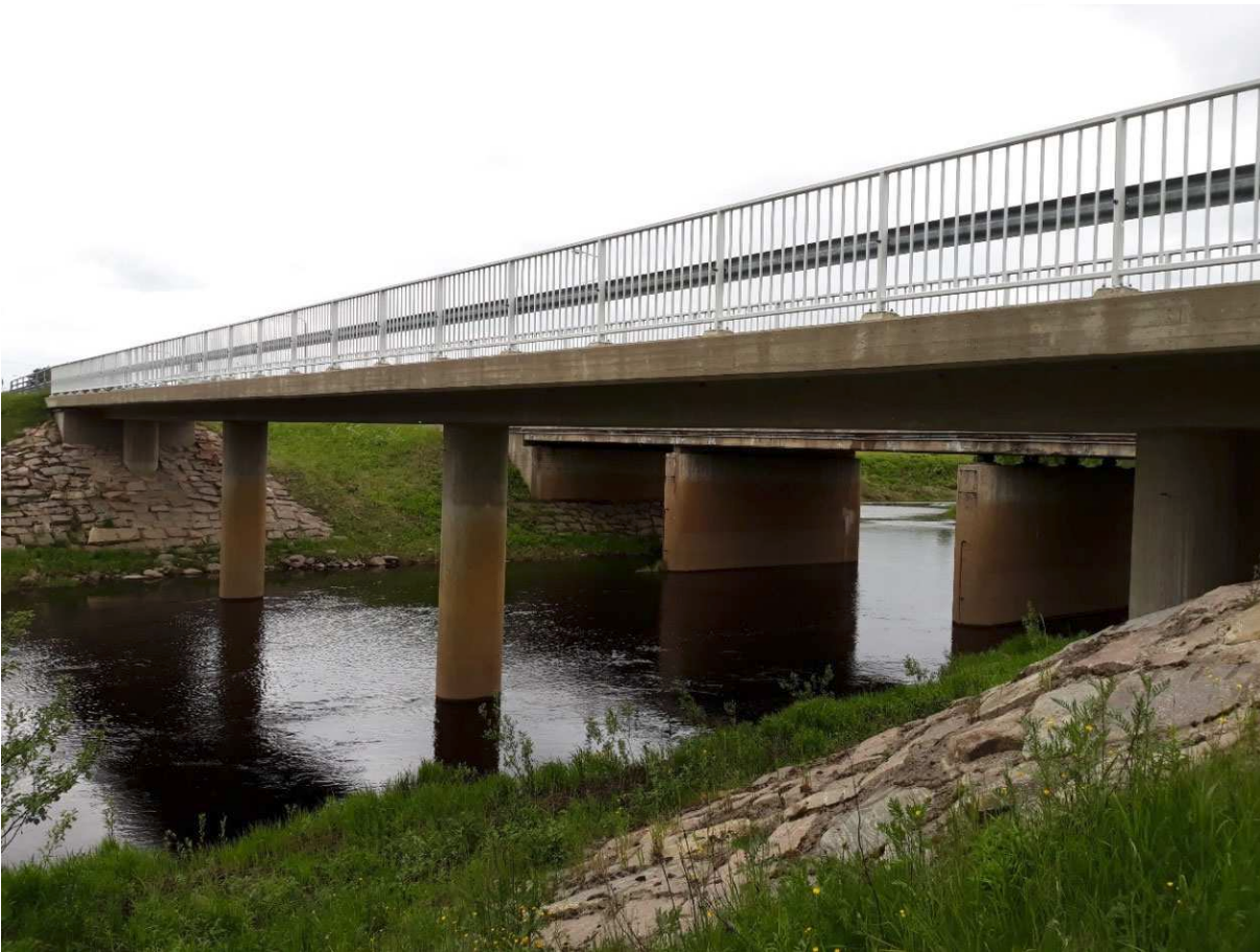
Kuva 9. Teräsbetoninen jatkuva ulokepalkkisilta (Bjup). Vaajoen raittisilta (L-2202), Tervola.
