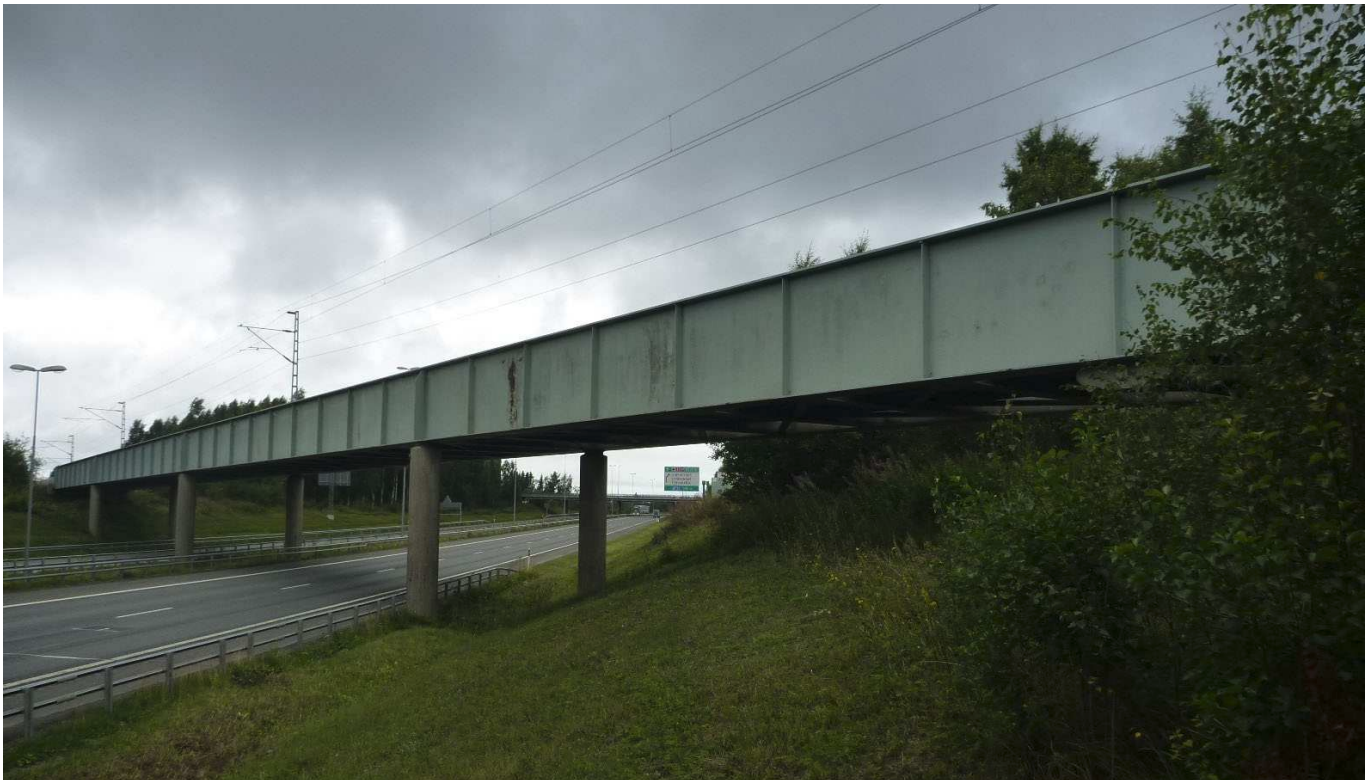
Kuva 32. Teräksinen jatkuva palkkisisilta (Tjp). Jarkon alikulkusilta (L-6001), Kemi.
