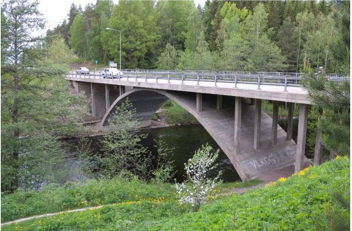
Kuva 17. Teräsbetoninen kaarisilta (Bkr). Käyräjoen silta (KaS-666), Kouvola.
