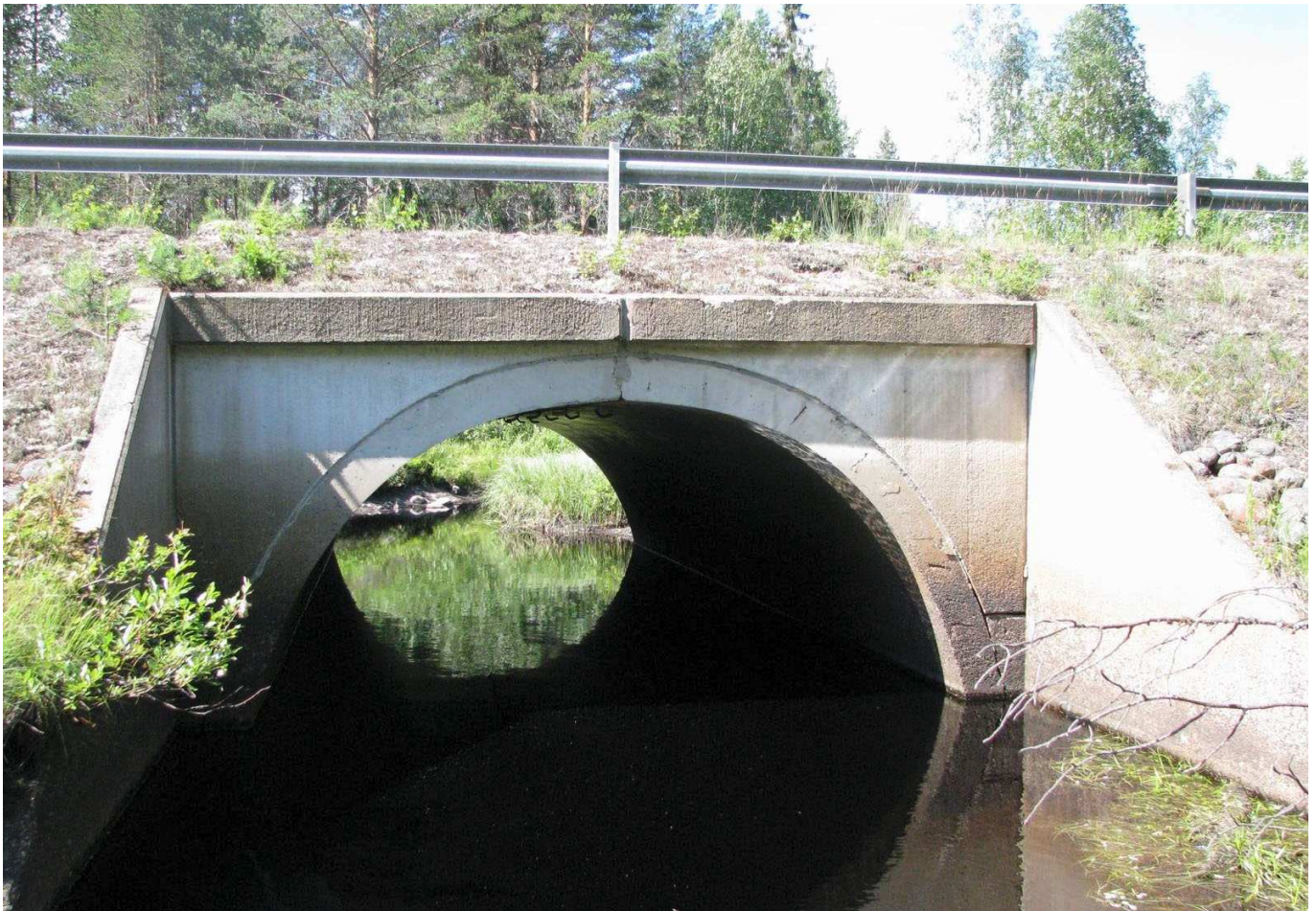
Kuva 19. Teräsbetoninen holvisilta, elementtirakenteinen (Bhe). Saaripuron silta (O-2403), Kuhmo.
