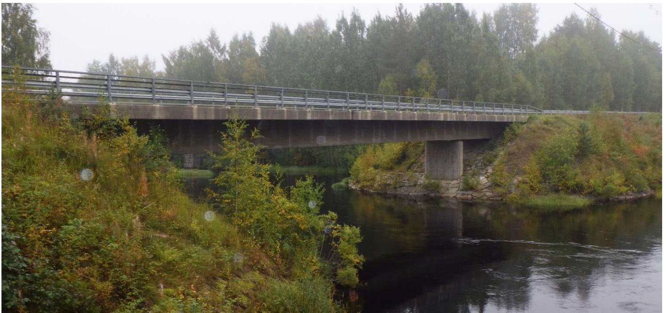
Kuva 16. Teräsbetoninen ulokekotelopalkkisilta (Bukp). Pisankosken silta (SK-198), Kuopio.
