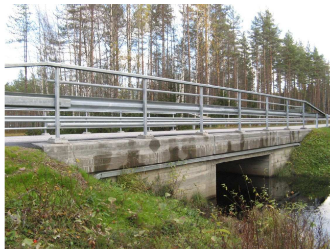
Kuva 13. Yksittäisen kaapelin sijoittaminen teräskoteloon.
