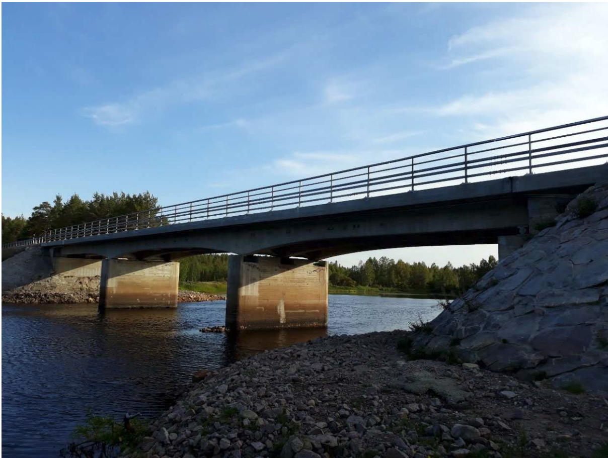
Kuva 7. Teräsbetoninen jatkuva palkkisilta (Bjp). Tievanpään silta (L-922), Ylitornio.
