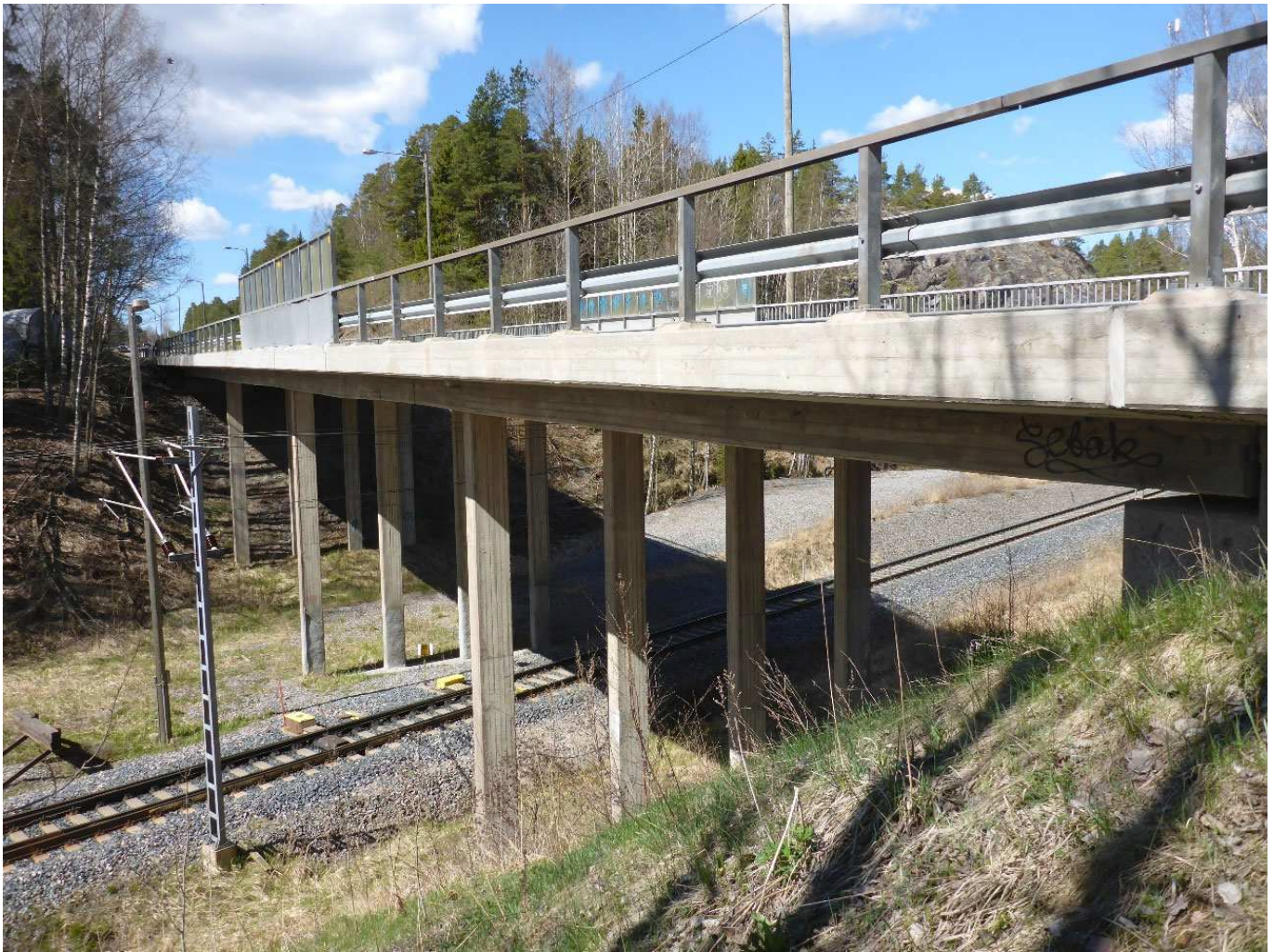
Kuva 3. Teräsbetoninen jatkuva laattasilta (Bj1). Pohjankurun ylikulkusilta (U-982), Raasepori.
