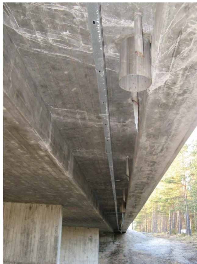
Kuva 14. Yksittäisen kaapelin sijoittaminen teräskoteloon.
