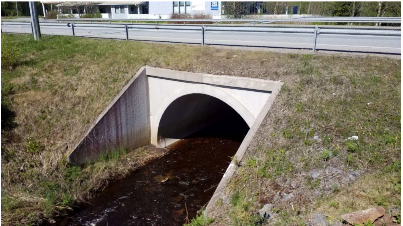
Kuva 24. Teräsbetoninen rengasholvisilta, elementtirakenteinen (Brhe). Mertapuron silta (V-1725), Alajärvi.
