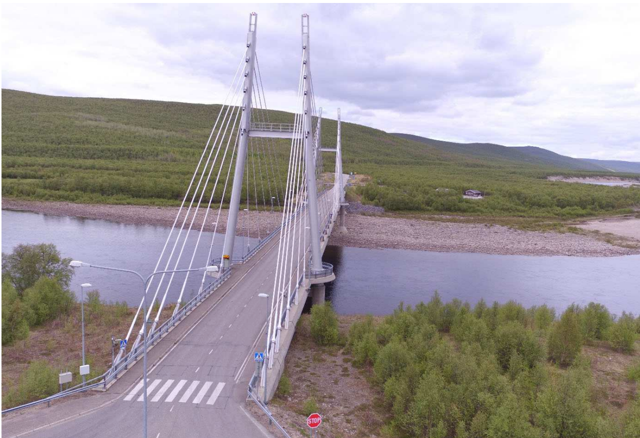
Kuva 42. Teräksinen vinoköysisilta, betonikantinen, liittorakenteinen (Tvksbl). Saamen silta Sami saldi (L-1915), Utsjoki.
