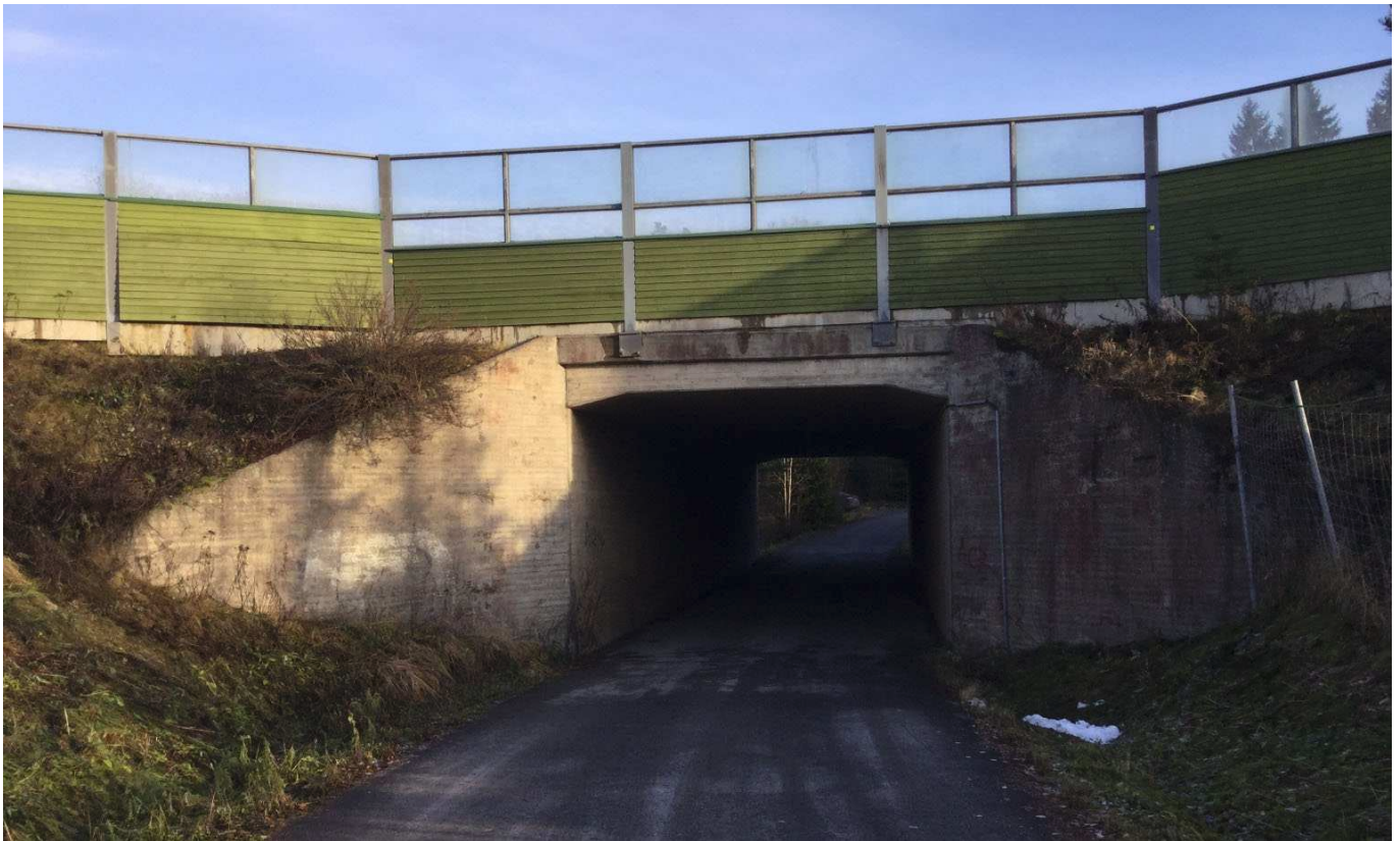
Kuva 21. Teräsbetoninen laattakehäsilta (Blk). Maisen risteyssilta (H-1067), Lempäälä.
