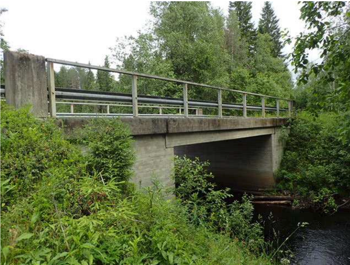
Kuva 1. Teräsbetoninen laattasilta (BI). Hurttajoen silta (SK-1232), Joensuu.
