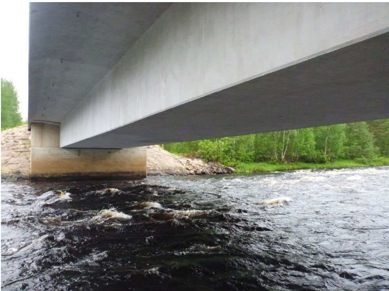
Kuva 14. Teräsbetoninen kotelopalkkisilta (Bkp). Meltausjoen silta (L-1513), Rovaniemi.
