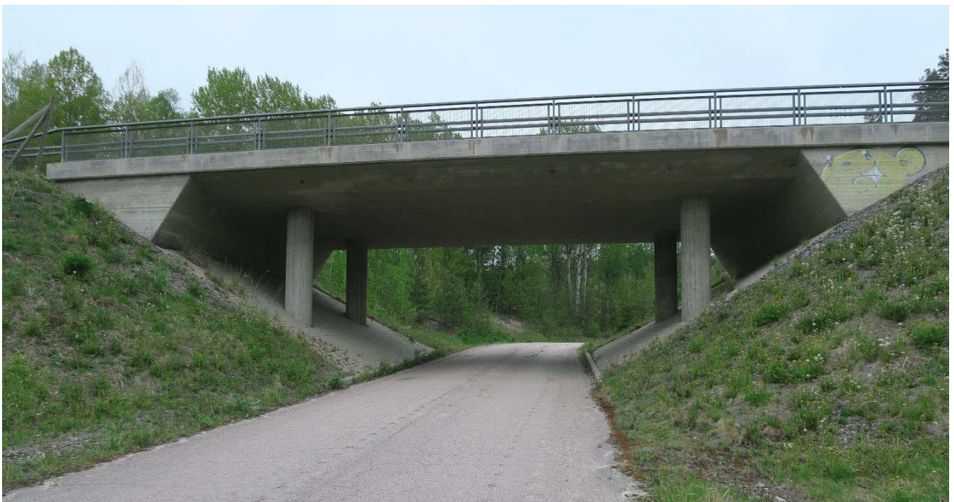
Kuva 4. Teräsbetoninen ulokelaattasilta (Bul). Raidiston risteysilta (H-2578), Orivesi.
