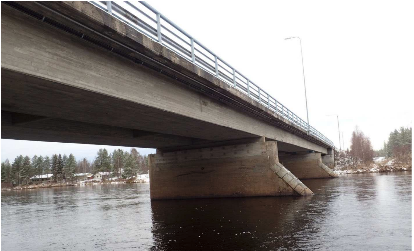
Kuva 15. Teräsbetoninen jatkuva kotelopalkkisilta (Bjcp). Pappilannivan silta (O-913), Oulu.
