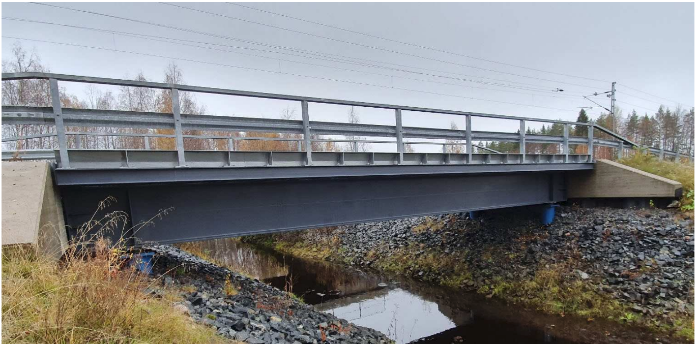
Kuva 31. Teräksinen palkkisisilta (Tp). Vaikonojan huoltotiesilta (O-4899), Oulainen.
