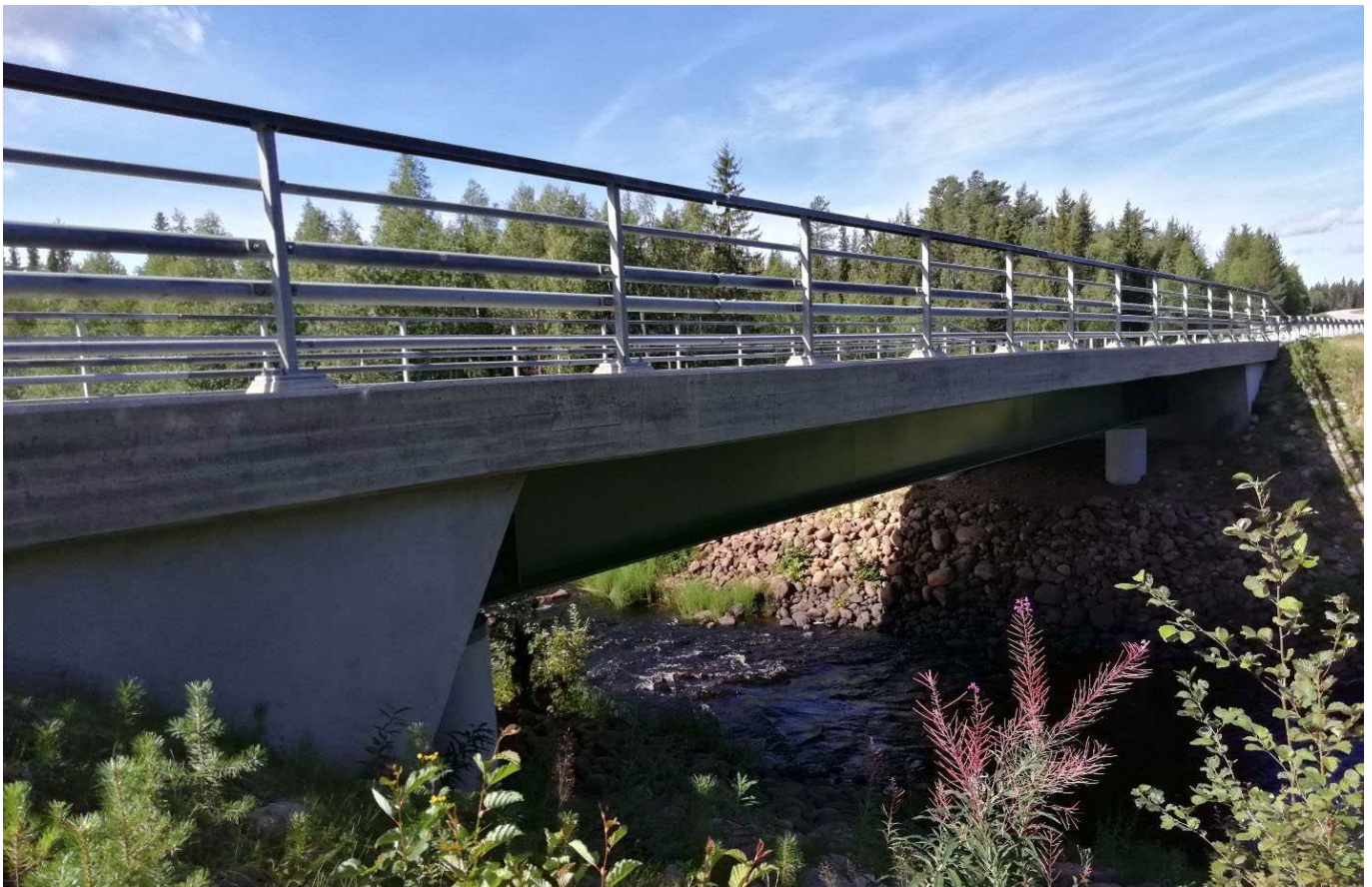
Kuva 34. Teräksinen ulokepalkkisilta, betonikantinen, liittorakenteinen (Tupbl). Laisentiajoen silta (L-2200), Rovaniemi.
