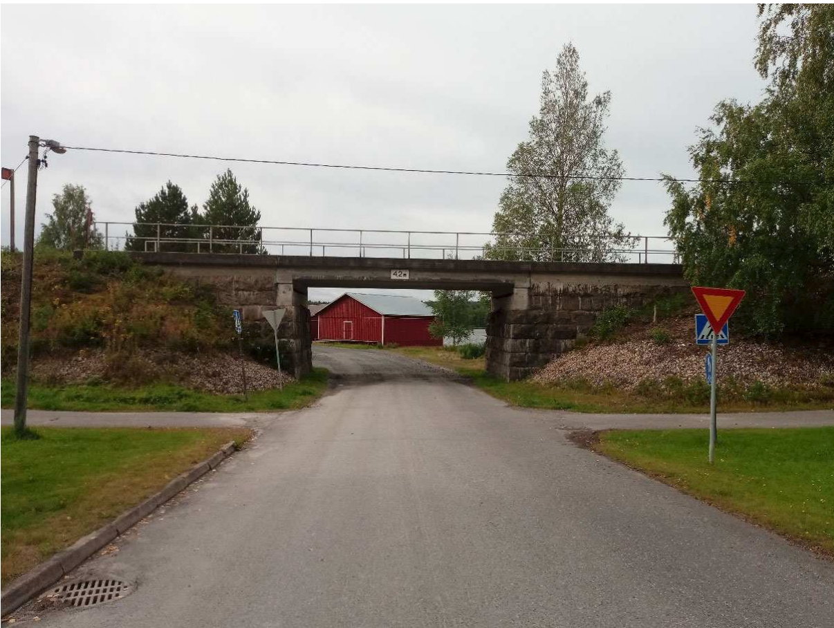
Kuva 10. Teräsbetoninen kaukalopalkkisilta (Bkaup). Maariankadun alikulkusilta (SK-2798), Nurmee.
