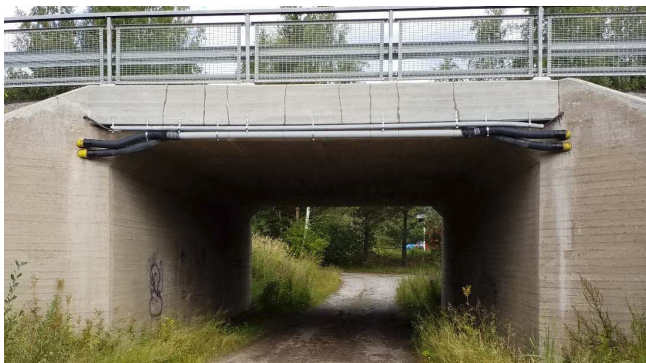
Kuva 6. Kaapelien suojaputket asennettuina laattakehäsiltaan. Suojaputket on porattu siipimuurien läpi.
