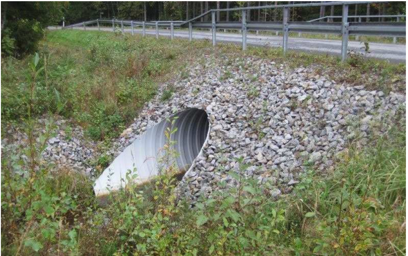
Kuva 46. Teräksinen putkisilta (Tputki). Kiviholman silta (V-5477), Kauhava.
