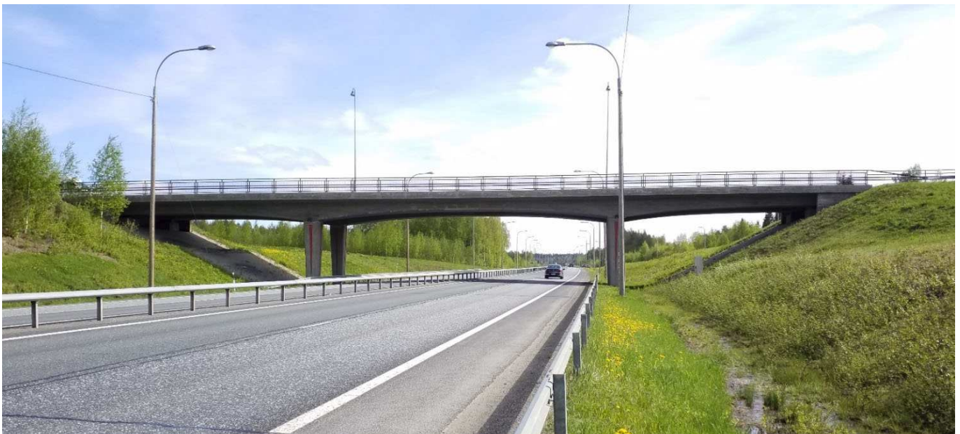
Kuva 26. Jännitetty betoninen jatkuva ulokepalkkisilta (jBjup). Reijolan risteyssilta (SK-1837), Joensuu.
