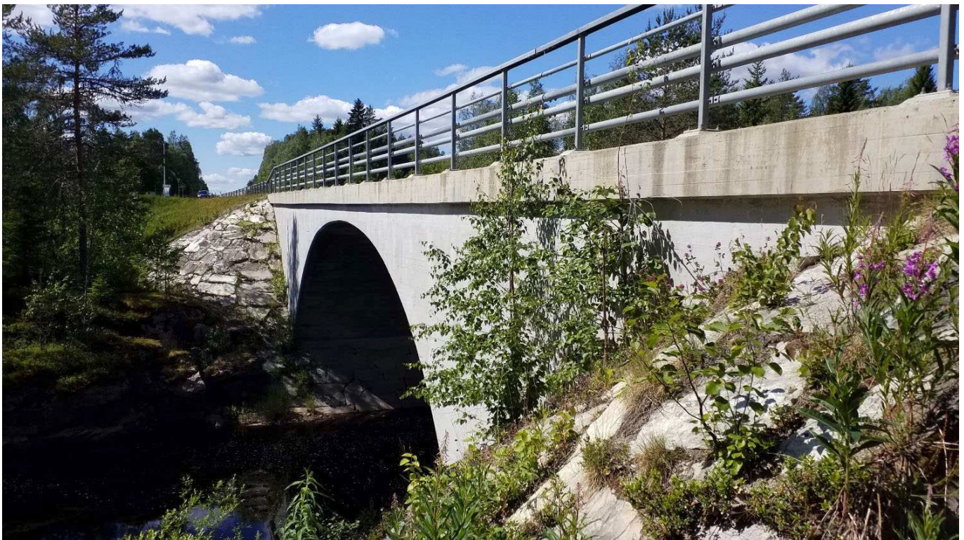
Kuva 18. Teräsbetoninen holvisilta (Bh). Lapinjoen silta (SK-444), Rautavaara.
