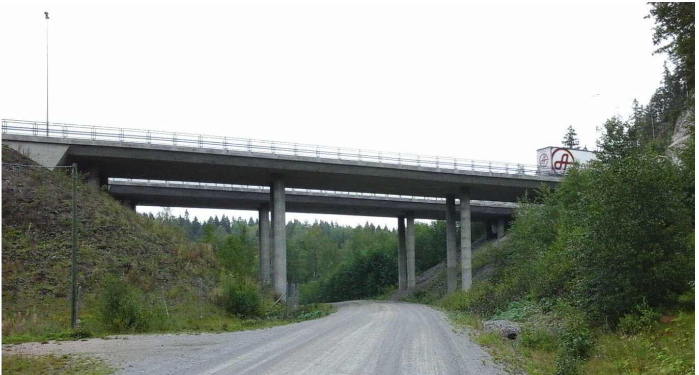
Kuva 5. Teräsbetoninen jatkuva ulokelaattasilta (Bjul). Talpelantien risteyssilta B (U-3630), Lohja.
