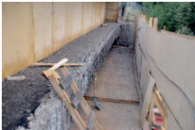
Kuva 1. Suojarakenteet reunapalkin purkutyötä varten.
