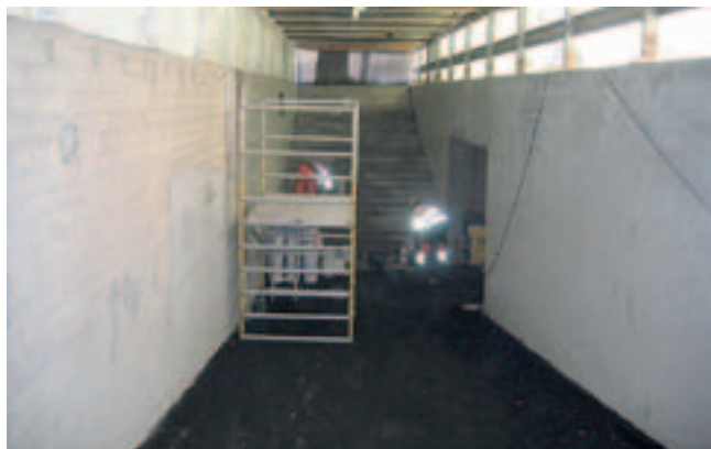
Kuva 2. Siisti ja hyvin suojattu työmaa.
