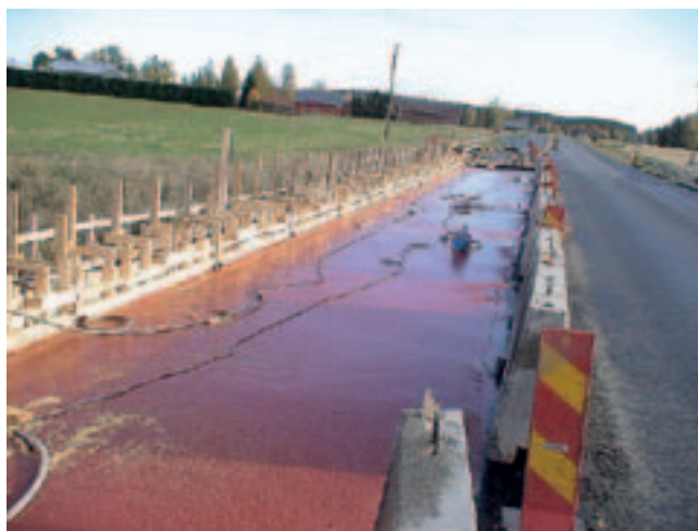
Kuva 11. Epoksitiivistystä käytettäessä haitallisten aineiden pääsy ympäristöön on yleensä helposti estettävissä.
