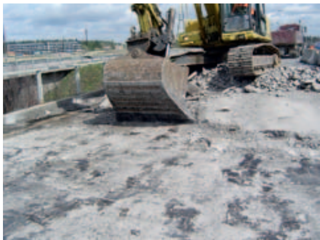
Kuva 10. Päällysteen poistoa kaivinkoneella.
