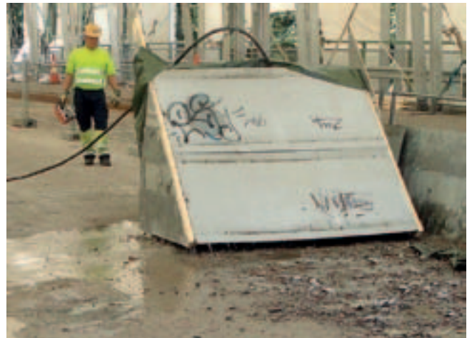
Kuva 5. Sillan kannen vesipiikkausta.
