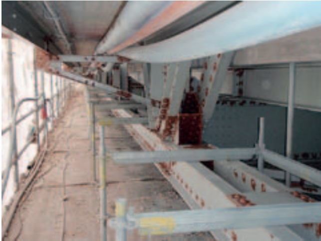
Kuva 8. Maalin leviäminen estetty asianmukaisilla suojuksilla.
