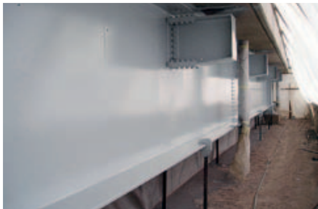
Kuva 3. Teräspalkin pintakäsittelyä varten tehty suo- jaus suuressa vesistö sillassa.
